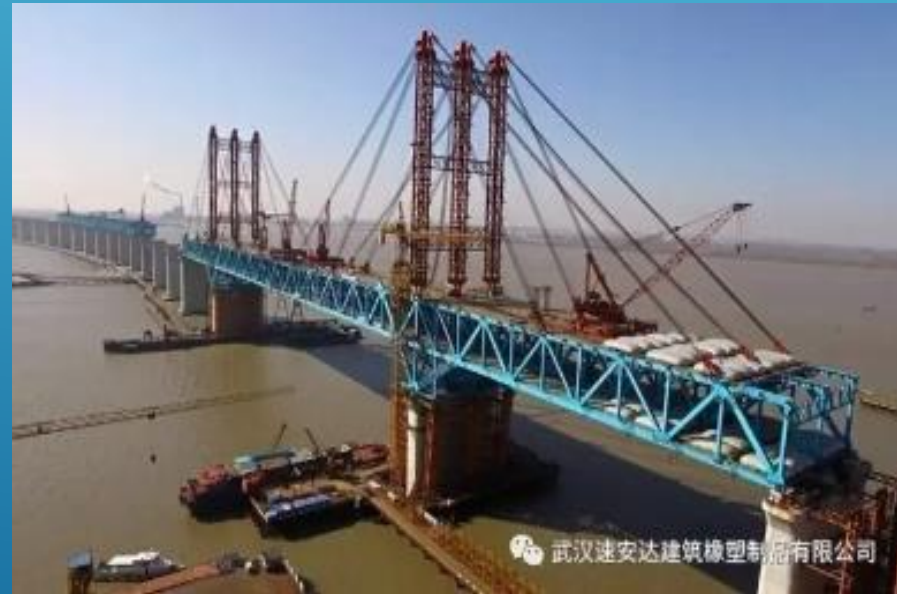
沪通长江大桥钢桁架配载
