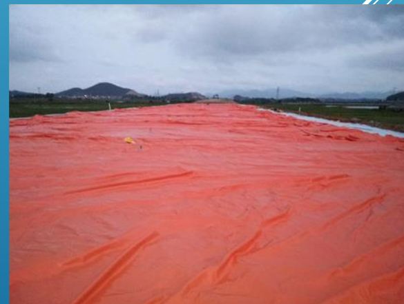
水袋摊铺完成
