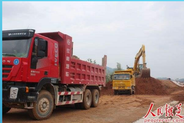
大量运土车、挖机、推土机配合堆土
