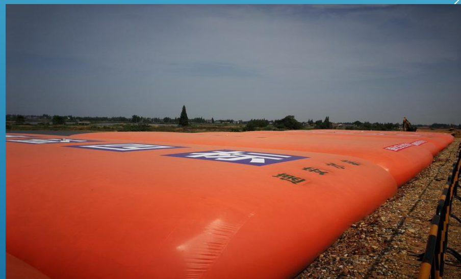
路基堆载水袋现场
