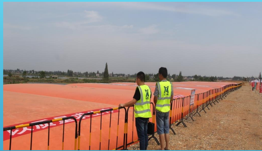
我公司施工人员现场安全巡查
