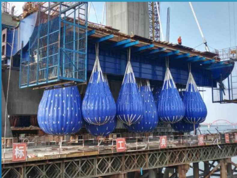
益阳大桥牵索挂篮吊袋预压
